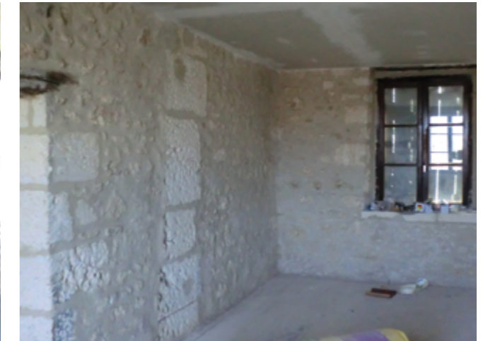
▲ ▶ Travaux de rénovation de l'ancien presbytère à Fresnoy-la-Rivière (ci-dessus : avant, à droite : après). © CCPV, A. Hammou
