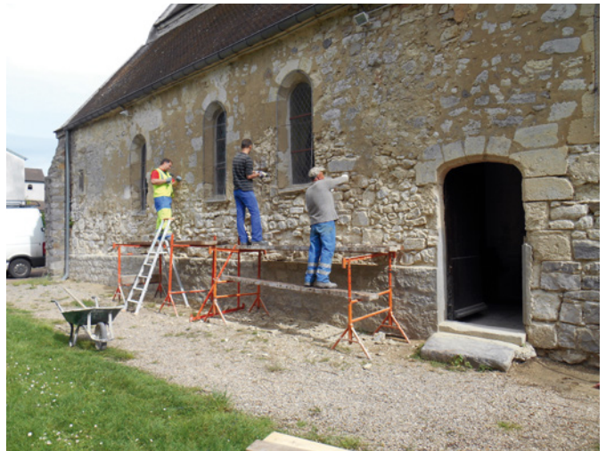
La façade de l'église de Rosoy-en-Multien a fait peau neuve grâce à l'intervention du chantier d'insertion. © CCPV, A. Hammou
