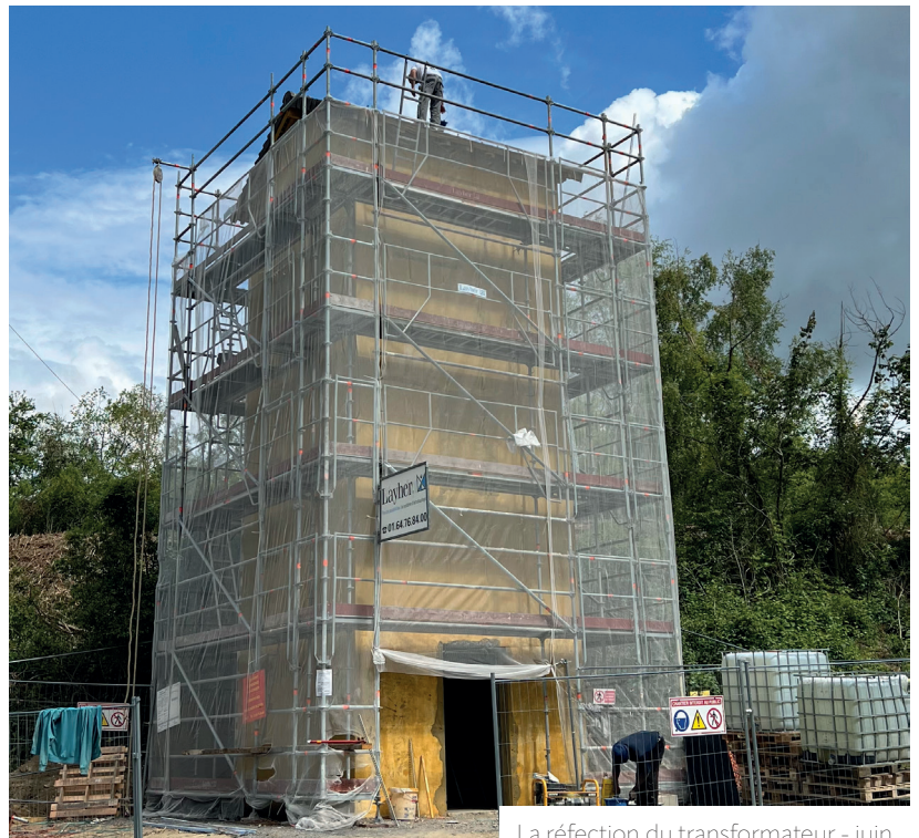
La réfection du transformateur - juin
