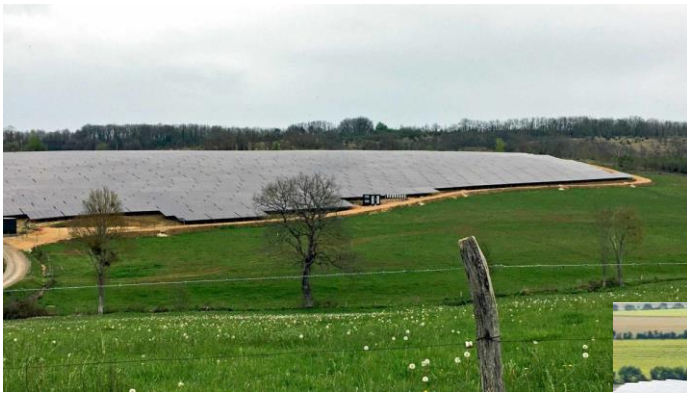
Centrale de Liéoux – Haute Garonne – 8 hectares
