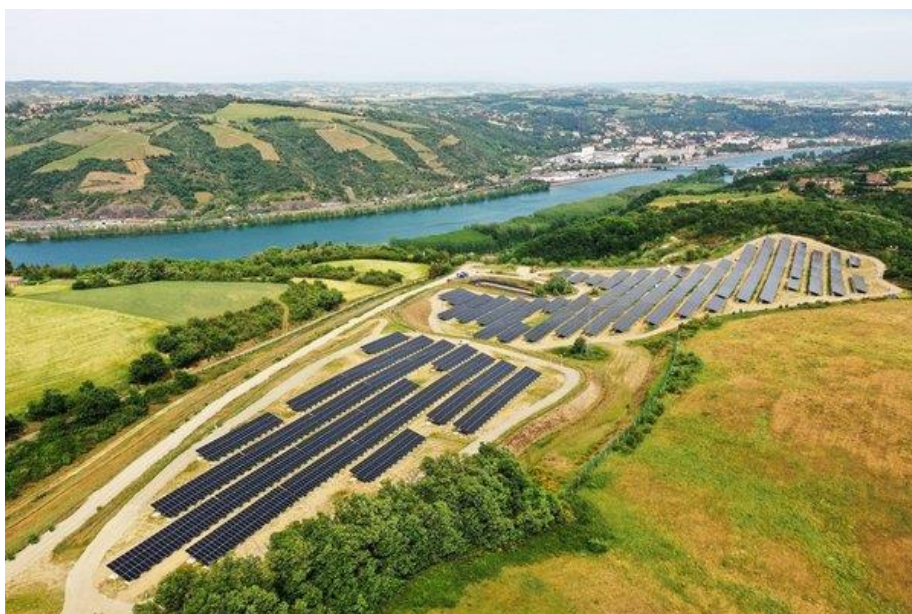
Centrale solaire de Saint Romain en Gal – Rhône – 5 hectares
