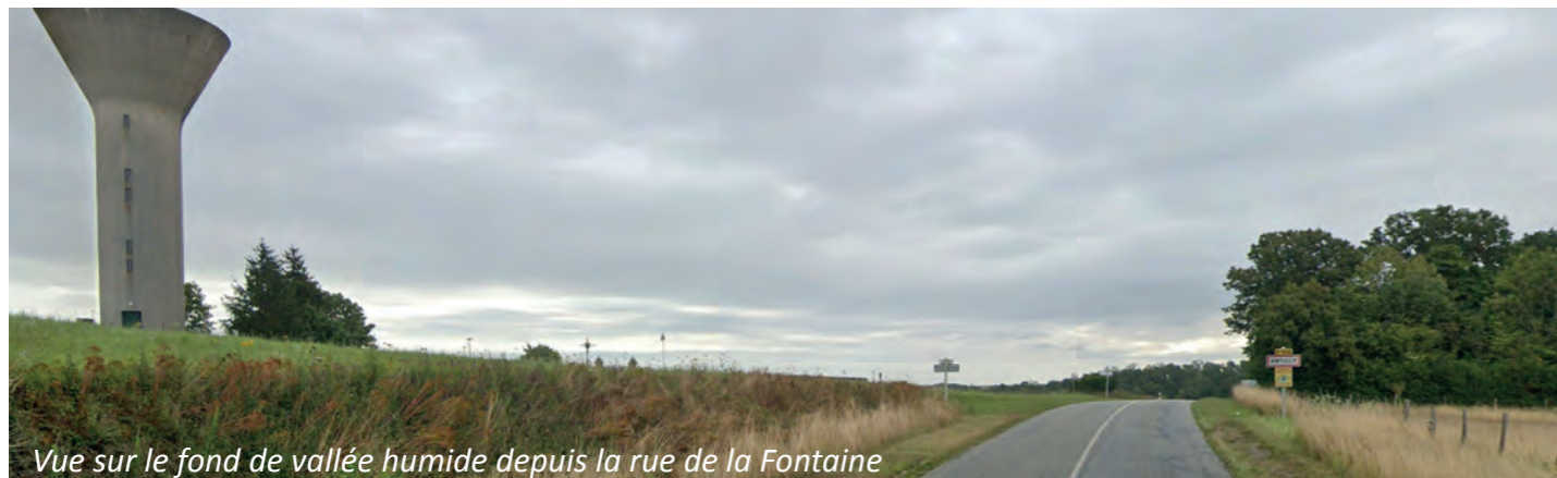
Vue de l'entrée sud depuis la RD n°20
